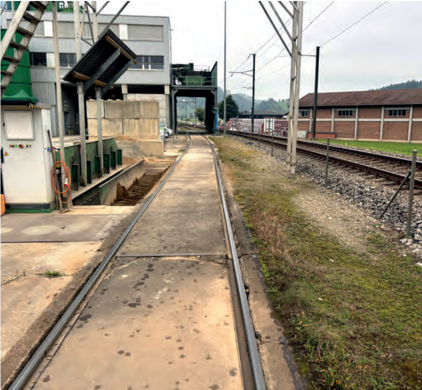
Auf diesem Bahngleis wird der Schotter angeliefert.
