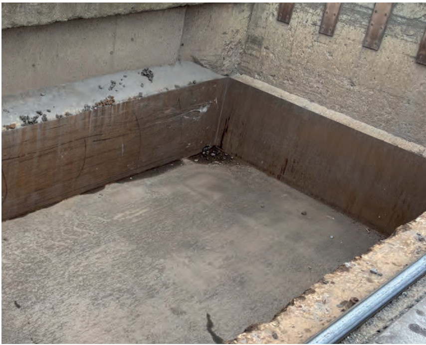
In diese Grube wird der angelieferte Altschotter gekippt.
